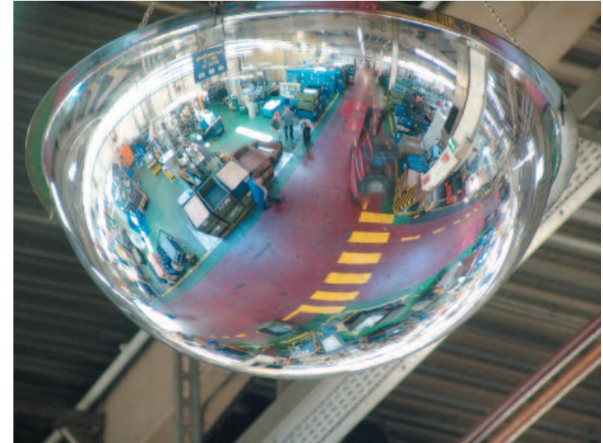
Bild 6-3: Kugelspiegel an unübersichtlicher Stelle
