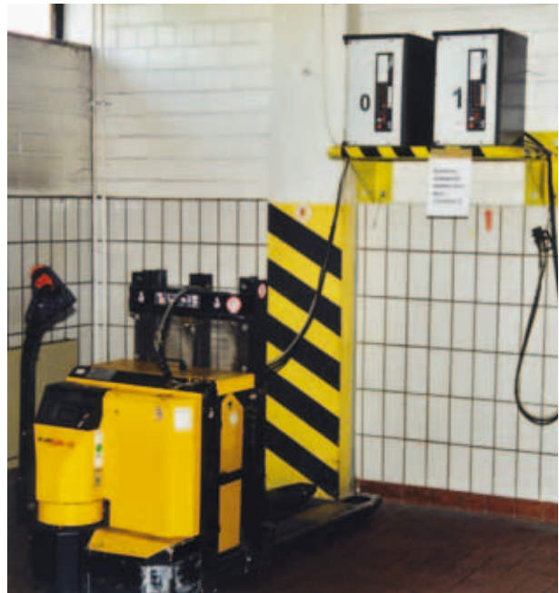
Abbildung 6: Batterieladestationen
